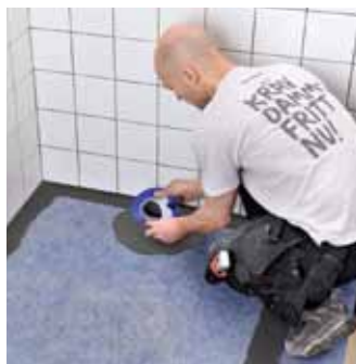
6. Trä på WetStop MP rörmanschett. Den ska sitta en bit upp/ut på röret för att säkerställa vattentätheten.
