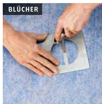
Placera den cirkelrunda skärmallen på skruven. Skär ut och markera tapphålen.
