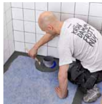
7. Förslut rörmanschetten genom att applicera SCHÖNOX iFIX eller HA.
