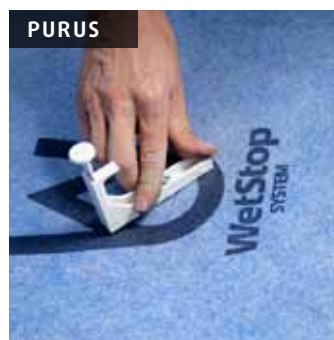
Tryck igenom fotens tapp så att den skär igenom SCHÖNOX WSF/brunnsmanschett.
