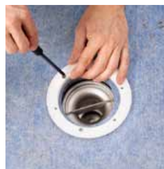
Skruva fast klämringen enligt Blüchers monteringsanvisning.
