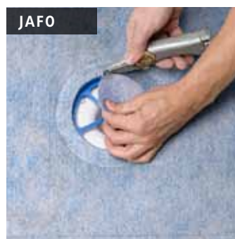
Skär ut hålet i SCHÖNOX WSF/ brunnsmanschetten, följ skärmallens insida.
