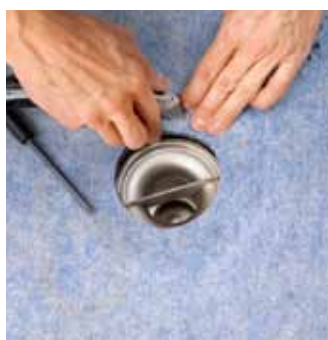
Klipp eller skär ut för tapphålen. Tryck tapparna igenom SCHÖNOX WSF/brunnsmanschett.
